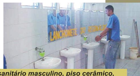
Lavatórios do sanitário masculino, piso cerâmico, revestimento das paredes em cerâmica, esquadrias em ferro com grade e vidro canelado, forro em PVC
