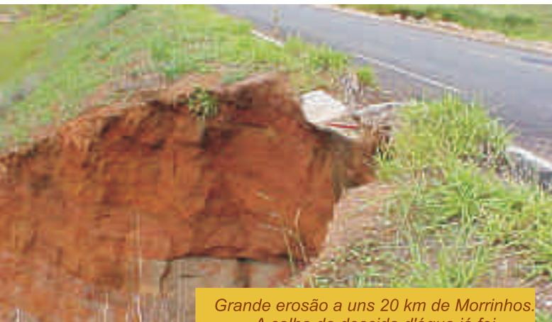
Grande erosão a uns 20 km de Morrinhos. A calha da descida d'água já foi engolida pela erosão
